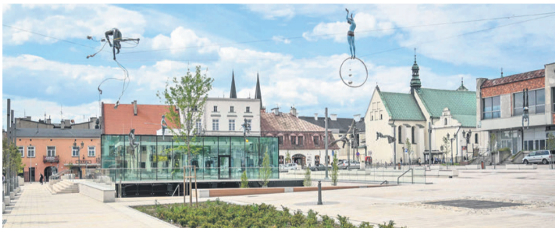
Przebudowa Starego Rynku. Wartość zadania - 26 968 452,08 zł; dofinansowanie z środków UE - 15 040 013,43 zł. fot. UM Częstochowy
